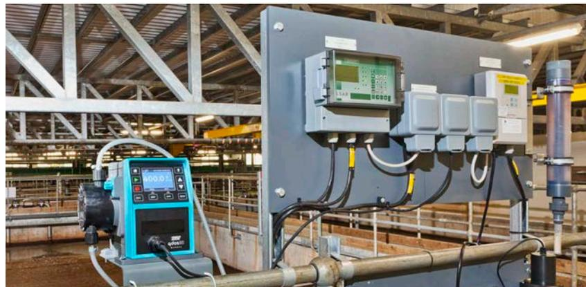
cessi di filtrazione finali. La pompa Qdos, con la capacità di fornire un flusso da 0,1 a 500 ml/min, offre a Dŵr Cymru Welsh Water una velocità di flusso regolare di 280 ml/min - e l'enfasi in questo caso è proprio sul termine "regolare".
